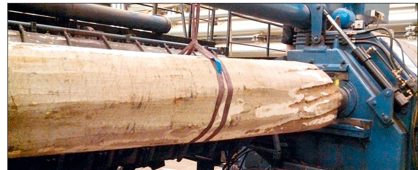
Der Stamm beim Einspannen in die Stay-Log-Anlage im Werk in Falkenhagen
